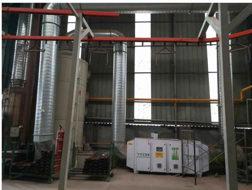
流平、烘干废气，天然气燃烧废气，喷塑固化废气处理设施
